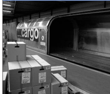
Mehrere – teils gedeckte – Anschlussgeleise verbinden Volketswil mit Europas Bahnnetz: Güterwagen entlasten die Strassen.
